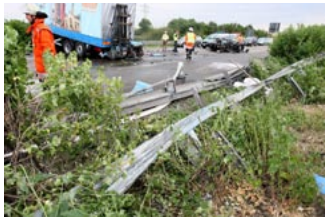
Bild 3: Lkw nach dem Durchbruch quer auf der Gegenfahrbahn Foto: Krauffmann, Stuttgart
