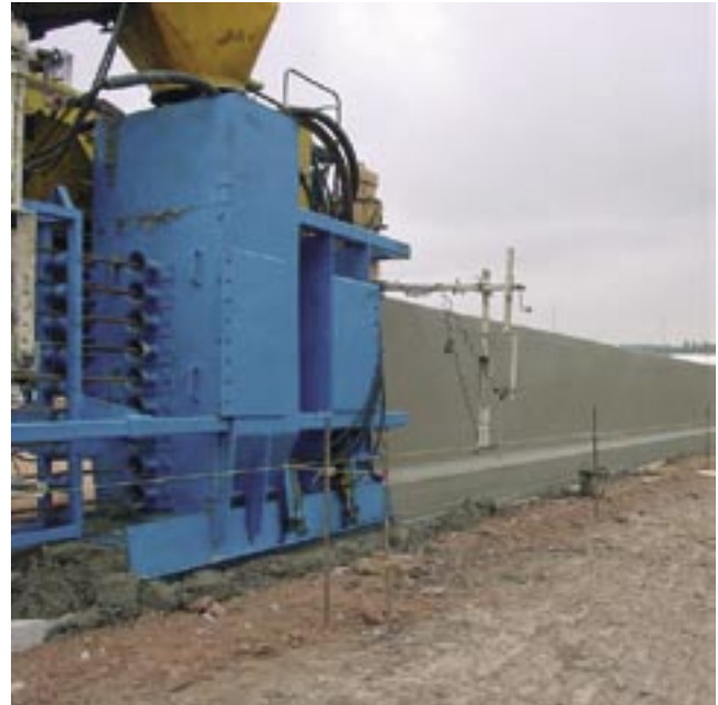
Bild 1: Errichtung einer Betonschutzwand mit Gleitschalungsfertiger (Step-Profil)
