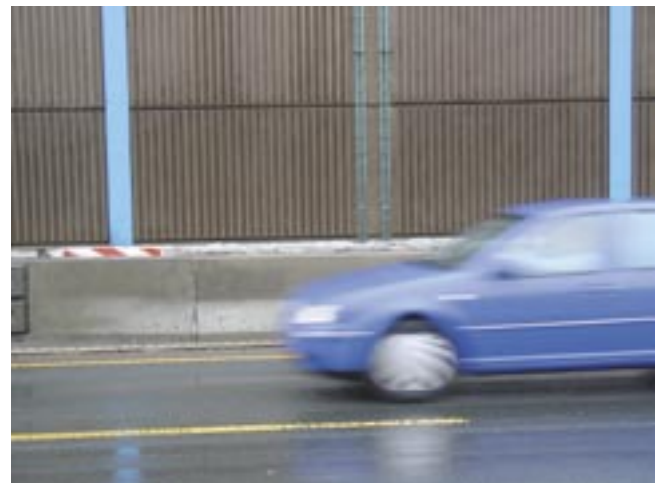
Bild 1: Ein dauerhafter Beton wird durch die Berücksichtigung so genannter Expositionsclassen für die Umgebungsbedingungen der Betonschutzwand erreicht, insbesondere für Spritzwasser-, Frost-, Frost-Tausalz- und Chloridbeanspruchung.
