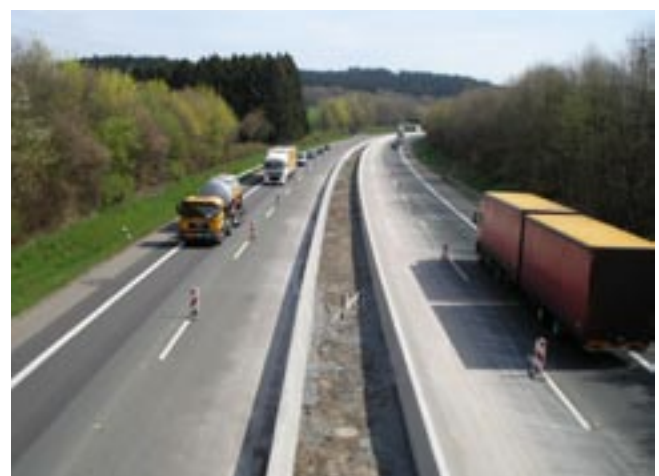
Bild 1: Mit dem Sondervorschlag Betonschutzwand konnte eine vollständige Versiegelung des Mittelstreifens verhindert werden
