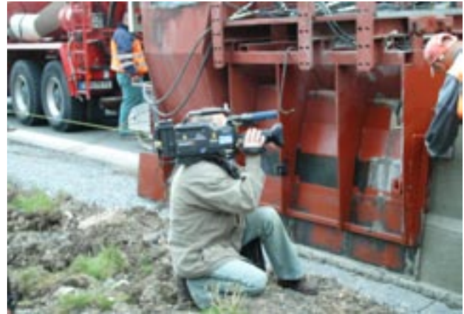
Bild 3: Detail Seitenschalung beim Gleitschalungsfertigern
