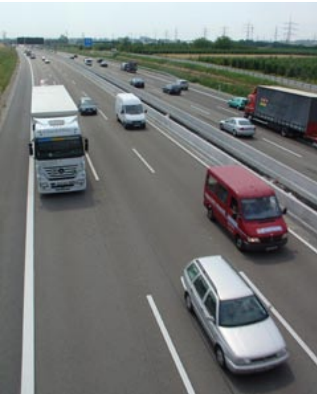
Bild 1: Neu errichtete Betonschutzwände auf der A 66 zwischen Wiesbadener Kreuz und Krifteler Dreieck
