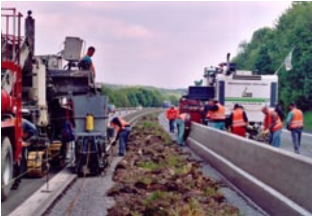
Bild 2: Einbau der Betonschutzwand mit Gleitschalungsfertigern
