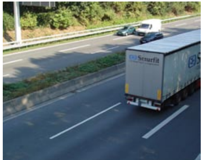
Bild 5: Mit Betonschutzwänden können Durchbrüche von schweren Fahrzeugen auf die Gegenfahrbahn sicher verhindert werden
