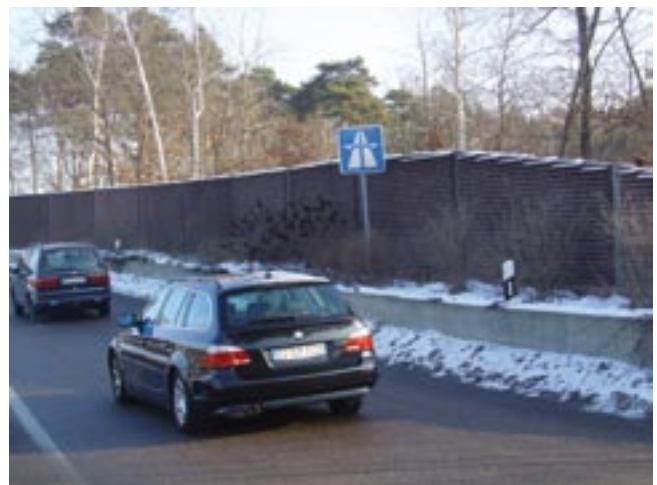
Bild 6: Betonschutzwände widerstehen dauerhaft Feuchte-, Frost-, Frost-Tausalz- und Chloridbeanspruchungen
