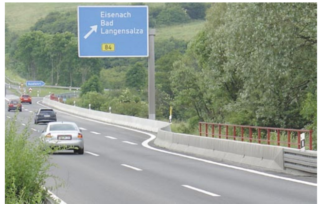
Bild 2: Betonschutzwände im Brückenrand- und Böschungsbereich auf der A4 bei Eisenach
