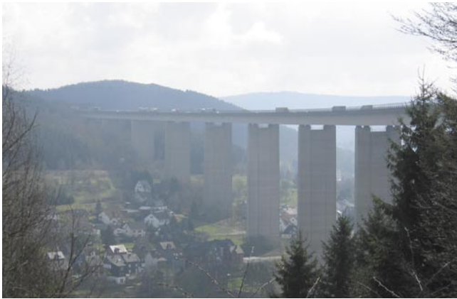
Bild 1: Die Brückenränder der Siegtalbrücke wurden mit Betonfertigteilsystemen der Aufhaltestufe H4b geschützt
